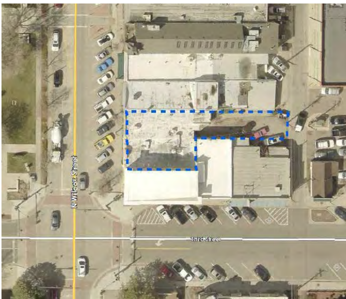
302 N. Wilcox Street
