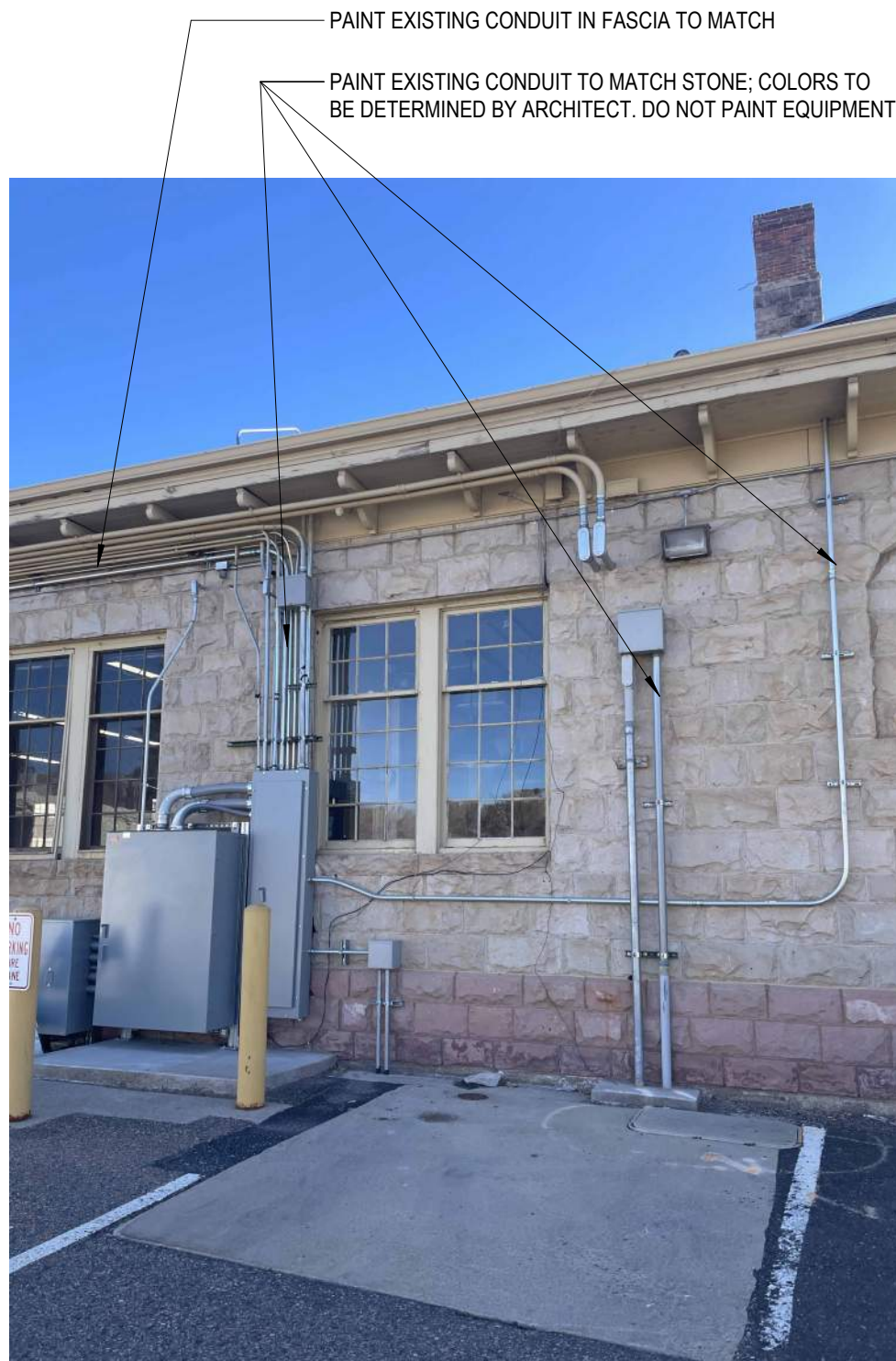
D2 PAINT CONDUIT NTS
